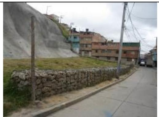
**Foto No 7.** Gaviones contruidos en la parte inferior para contener el terreno.
