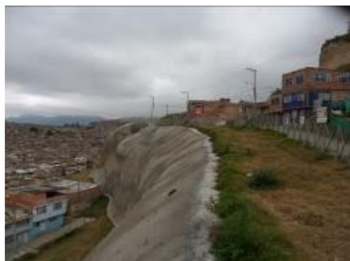
**Foto 4.** Panorámica del talud protegido con concreto lanzado y del cerramiento perimetral en la parte superior.
