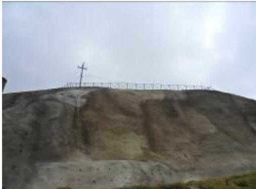
**Foto 3.** En la parte superior del talud se construyó un cerramiento perimetral en malla eslabonada, con el fin de brindar seguridad.
