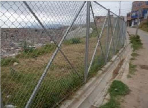
**Foto No 5.** Detalle del cerramiento en malla eslabonada y de la cuneta prefabricada instalada perimetral en el borde superior del talud.
